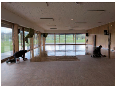
Rénovation du parquet de la salle festive
