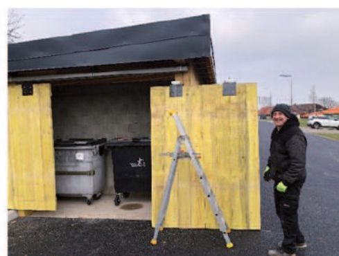
Réalisation du local « poubelles »
