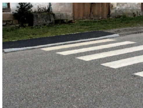
Mise en place de trottoirs-bateaux
