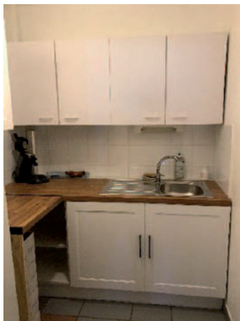
Rénovation de la cuisine de la mairie
