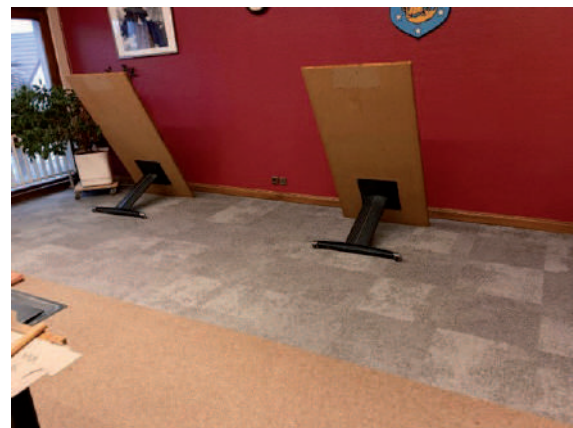
Remplacement de la moquette de la salle du Conseil Municipal
